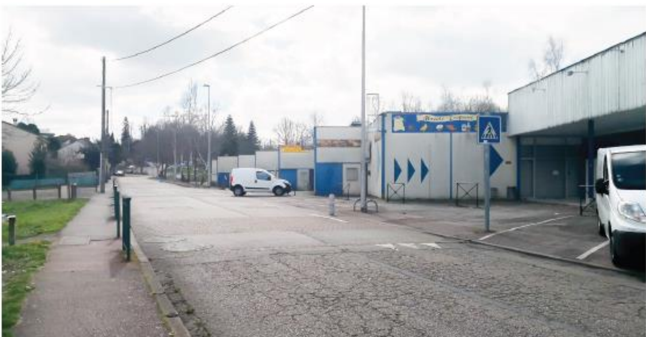
Depuis la rue des Portes Ferrées en cœur de quartier, une compréhension toujours difficile du site
